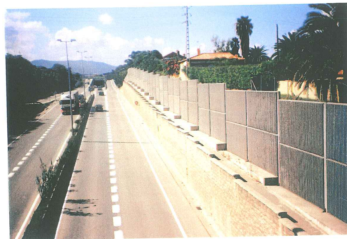
FOTO 12. MURO DE CONTENCIÓN EN ZONA RESIDENCIAL DE MARGEN IZQUIERDA DEL ACCESO AL PUERTO
